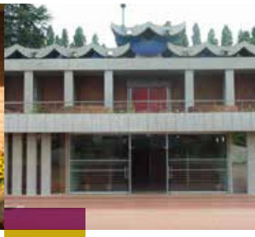
Un crématorium entièrement rénové pour l'accueil des familles, avec un ascenseur pour les personnes à mobilité réduite (PMR) et équipé d'une nouvelle ligne de filtration afin de réduire les rejets atmosphériques.
