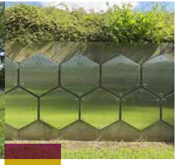
Des enfes aménagés en hauteur.
