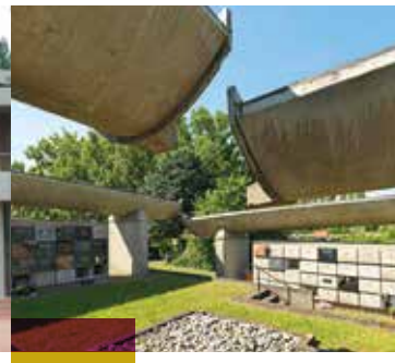
Un columbarium , ouvrage emblématique de l'architecte Robert Auzelle, ainsi qu'un espace paysager destiné aux urnes cinéraires.
